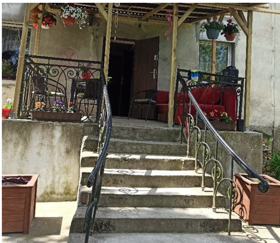
Schody z tyłu dworu, zdjęcie z 2022r.
