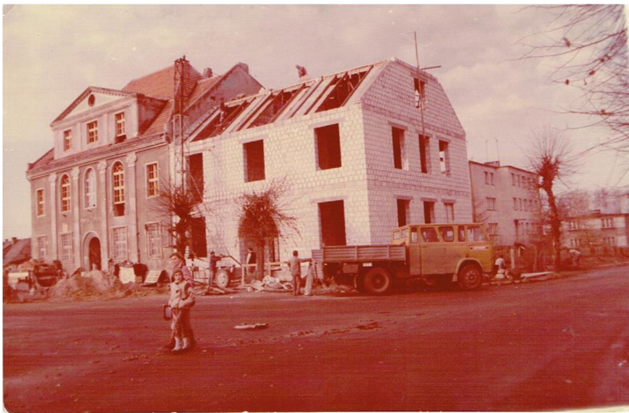
Zdjęcie ze zbiorów Huberta Pietryki, rok 1987, budowa prawego skrzydła Urzędu Gminy
